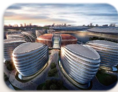
城市综合体项目 上海虹桥世界中心
